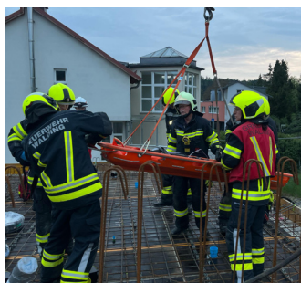
Auch die Rettung mittels Korbschleiftrage wurde auf der Baustelle geübt.
