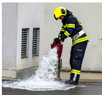
Dominik Breitenfellner spült den Hydranten vor, bevor er den Schlauch anschließt.
