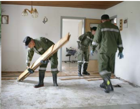
Die Aufräumarbeiten beginnen.
