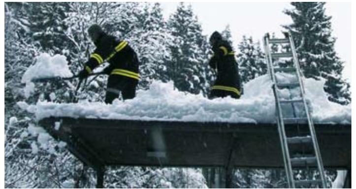
Auch kleinere Dächer, wie hier ein Vordach, bogen sich unter den Schneemassen und mussten sofort abgeschaufelt werden.
