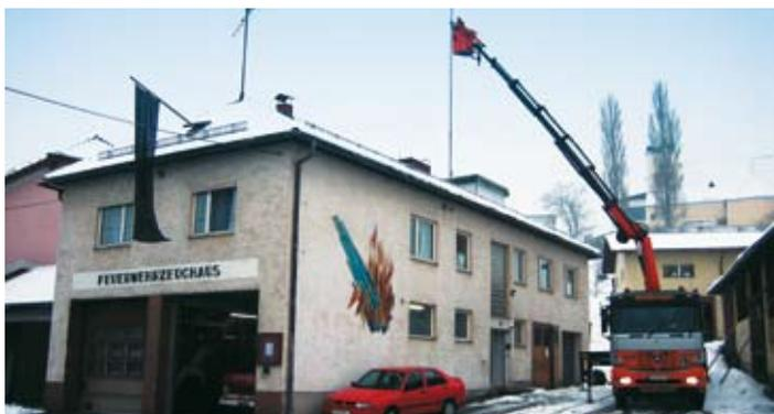
Der Teleskop-Funkmast musste aus den Halterungen im Schlauchturm ausgefädelt werden. Dazu benötigten wir den Autokran der Firma Zellinger.
