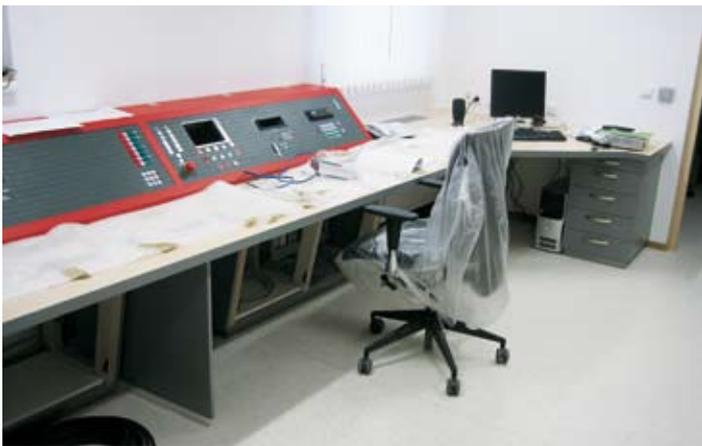
Funkpult im neuen Feuerwehrhaus vor Einbau des Funkgerätes und des Bedienfeldes für die Sirenensteuerung.
