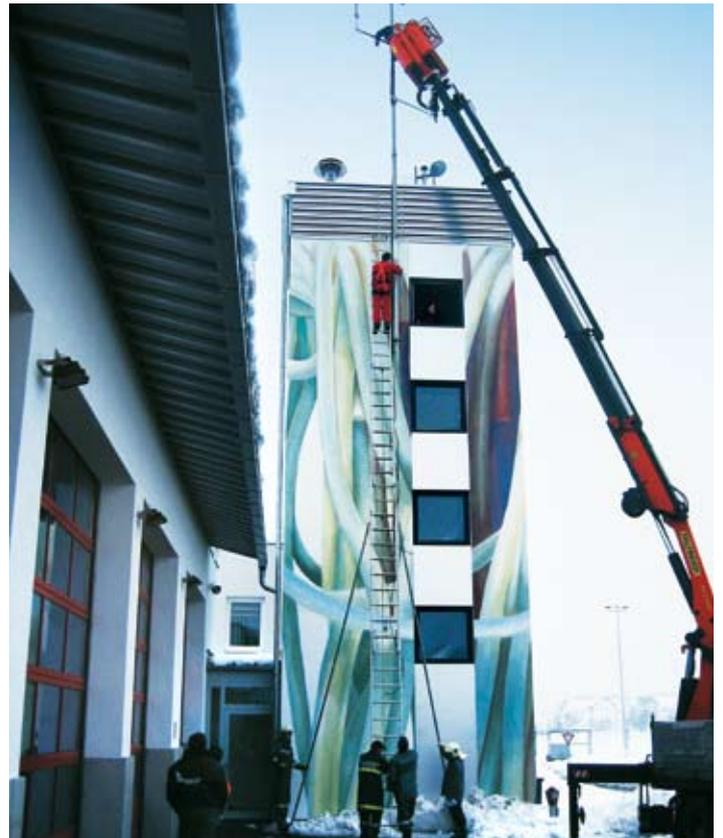
Montage des Funkmastes am neuen Schlauchturm mit Autokran und 15m-Schiebeleiter.
