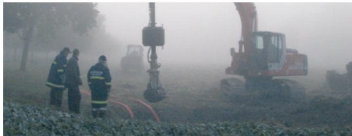
Für die Löschwasserversorgung der Ortschaft Purwörth wurde bereits in den 50er Jahren ein Löschwasserbrunnen errichtet. Bei mehreren Pumpversuchen wurde festgestellt, dass der Brunnen nicht mehr die für die umliegenden landwirtschaftlichen Objekte notwendige Löschwassermenge liefert. Wegen mehrerer Hochwässer ist der Brunnen
